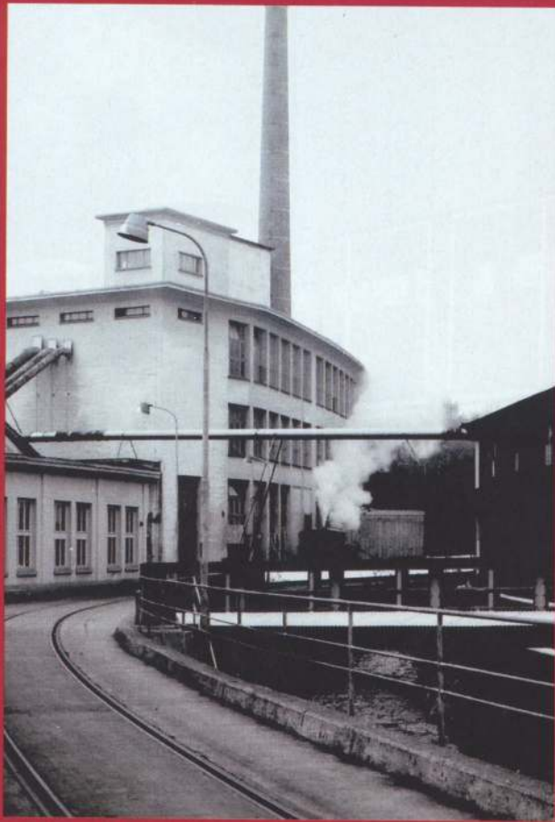
Bild 25: Auf der Fahrt zur Remise nach getaner Arbeit. Der große Kamin gehört zum Kesselhaus, mit dem die Gebäude geheizt wurden. Hier werden auch die Holzabfälle der Schreinerei und der Modellschreinerei verbrannt.
