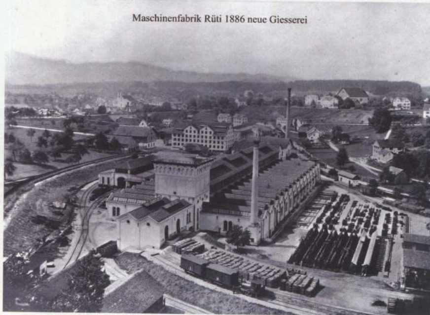
Bild 11: Gut zu erkennen die komplizierte Streckenführung. Ganz links außen ist der aufgeschüttete Damm erkennbar. Unten in der Bildmitte ist die Lok 1 mit zwei Güterwagen.
